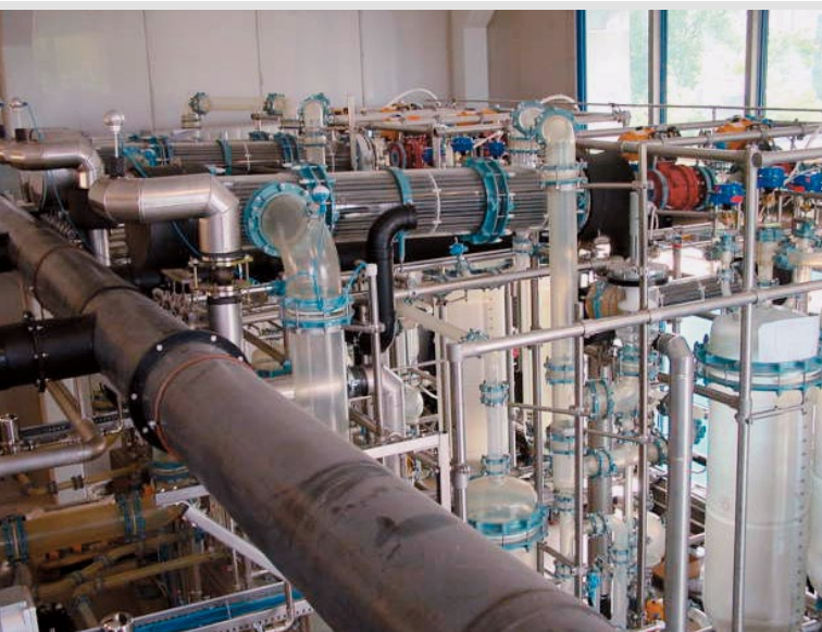
High performance SiC silicon carbide heat exchanger Leistungsfähige SiC Siliziumkarbidwärmetauscher
